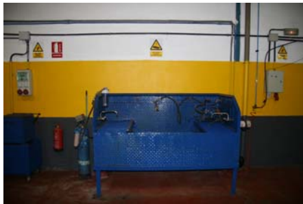
Prueba hidráulica Medidor
